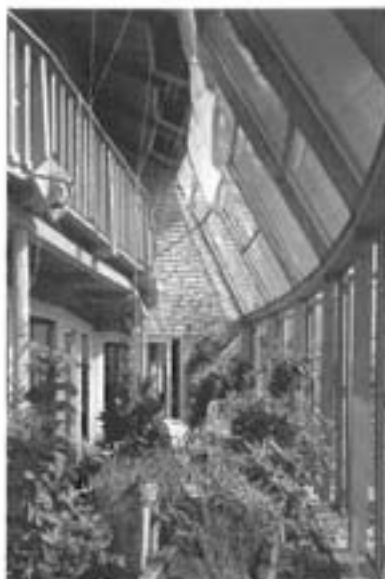
暖気は二階、三階に自然に循環します
