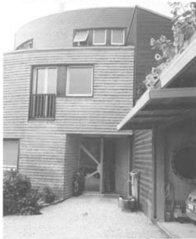
丘に埋め込まれた木造ガレージ
