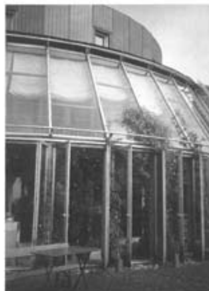
南向きの温室とソーラーパネル
