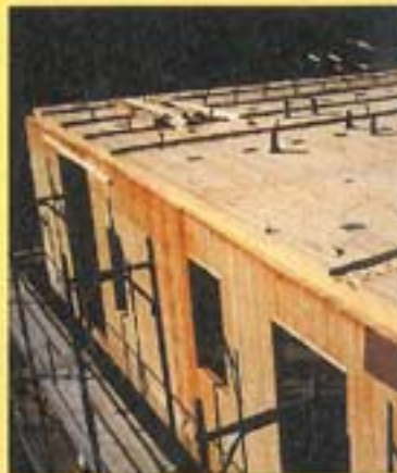
Souvenir de chantier... C'était avant le béton.
