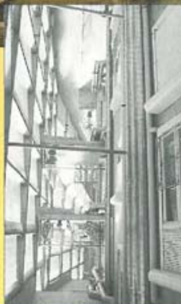
Des coursives protégées par une peau de verre bordent la route.
